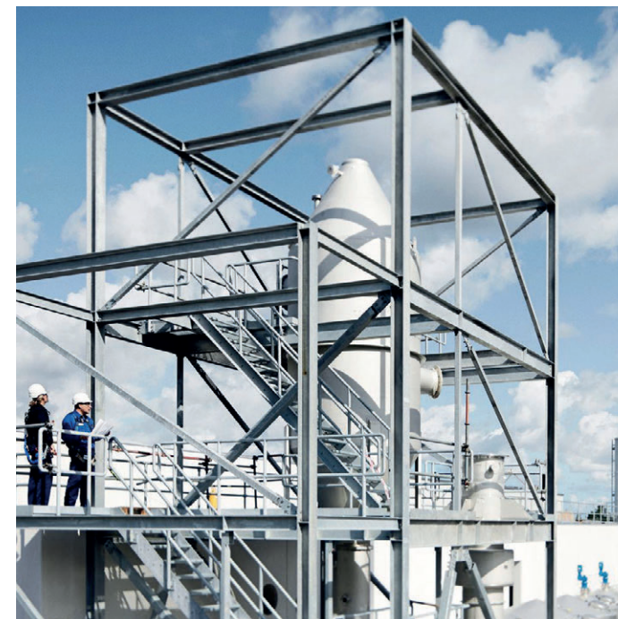
Topsoes katalysatorfabrik i Frederikssund, Danmark.
